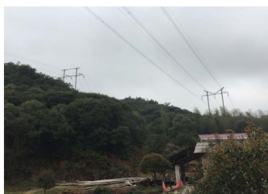
跨越220kV沙丛 I、II 线
