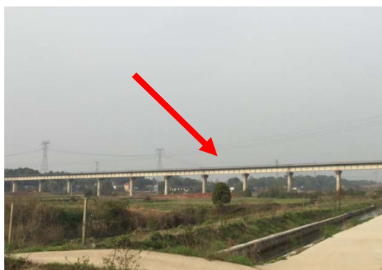
跨越京广铁路
