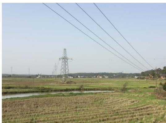
跨越韶山换流站接地极线路
