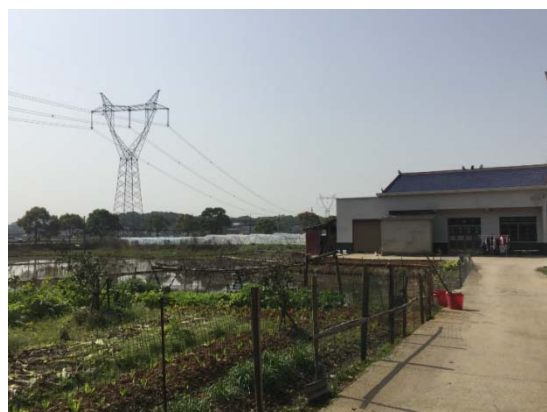
跨越500kV复沙 I 线
