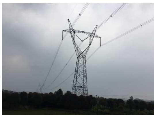
跨越500kV昆沙线
