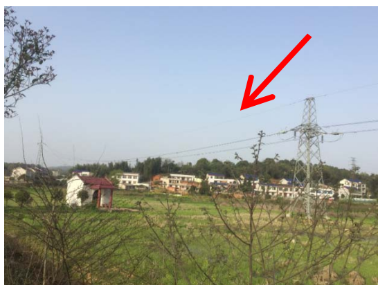
跨越韶山换流站接地极线路
