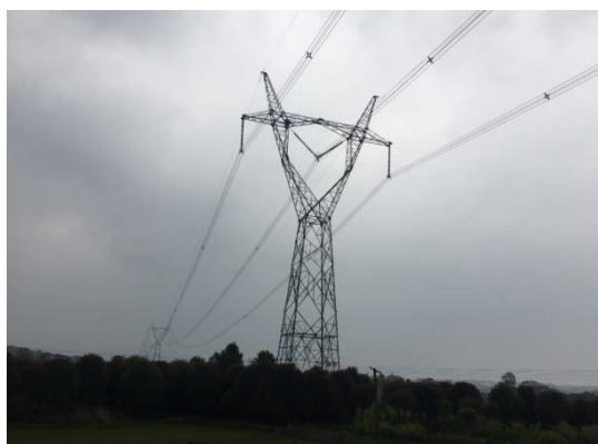
跨越500kV昆沙线
