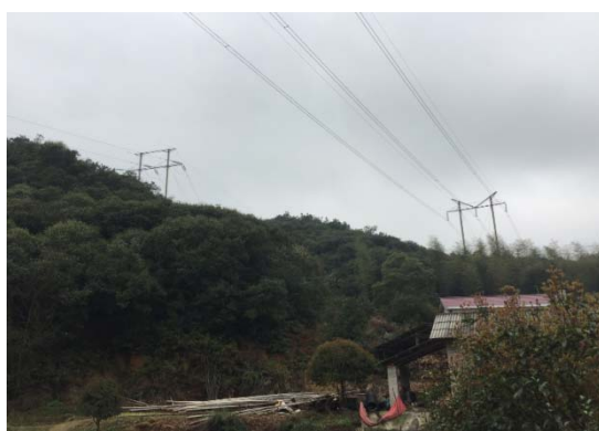
跨越220kV沙丛 I、II 线
