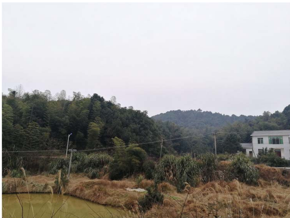
图 4-1 望城 500kV 变电站站址环境现状
