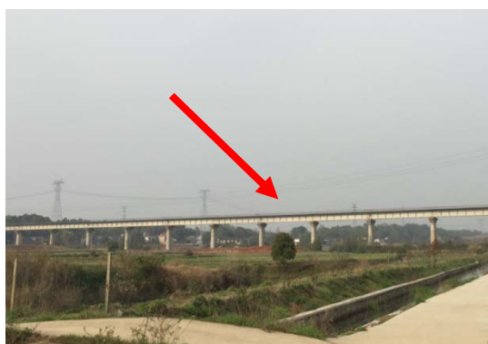
跨越京广铁路
