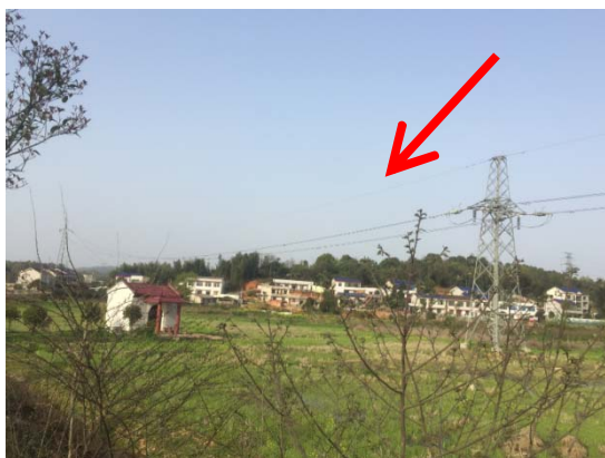
跨越韶山换流站接地极线路
