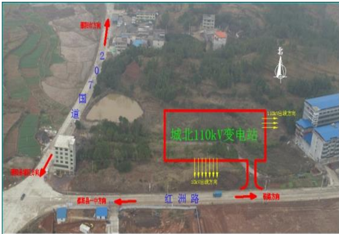
城北 110kV 变电站俯视图
