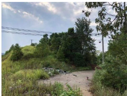
城北 110kV 变电站站址现状
