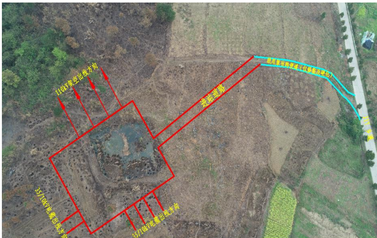
五峰铺 110kV 变电站俯视图
