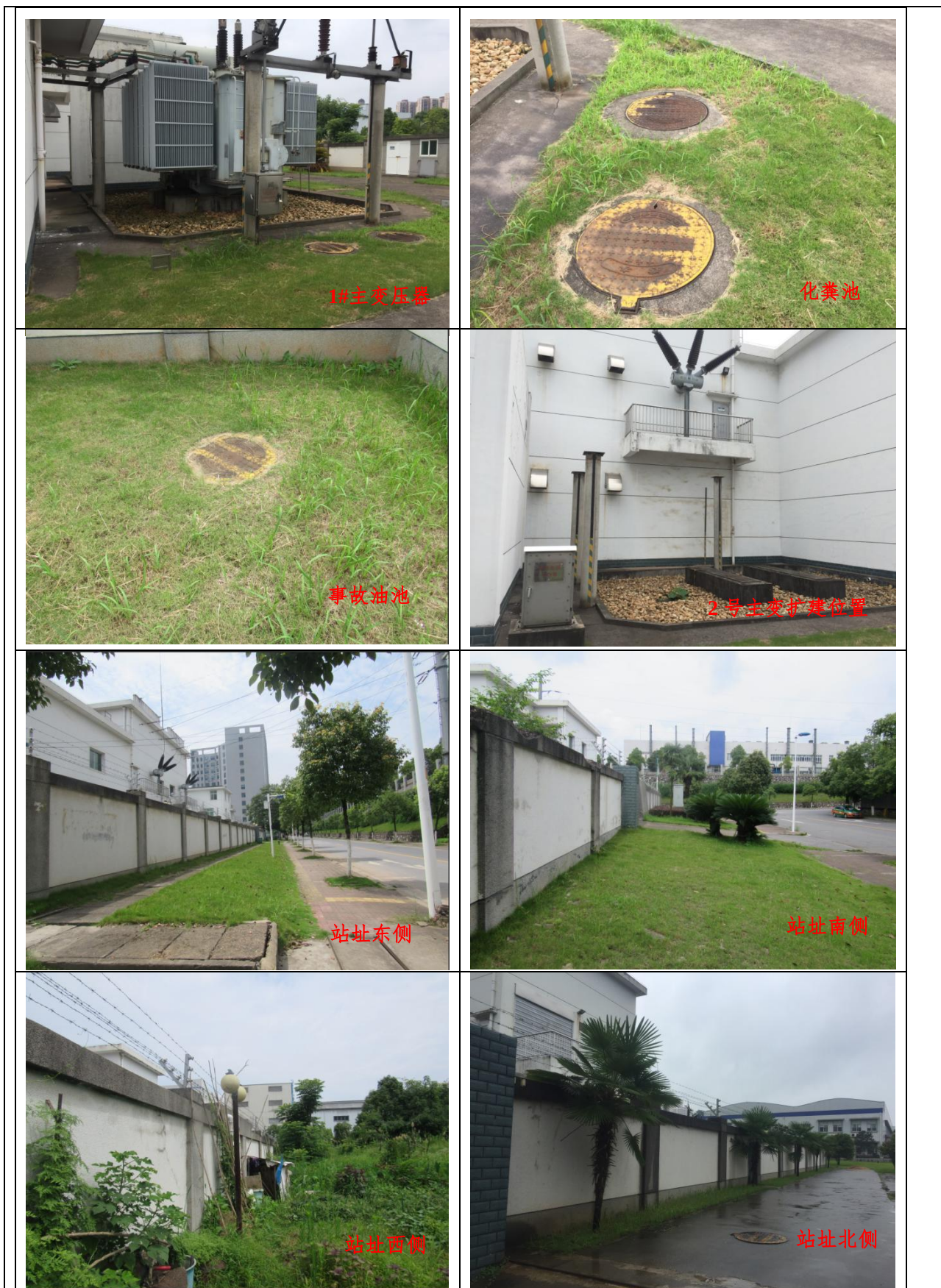
图 5 坚固 110kV 变电站站内及周边环境现状
