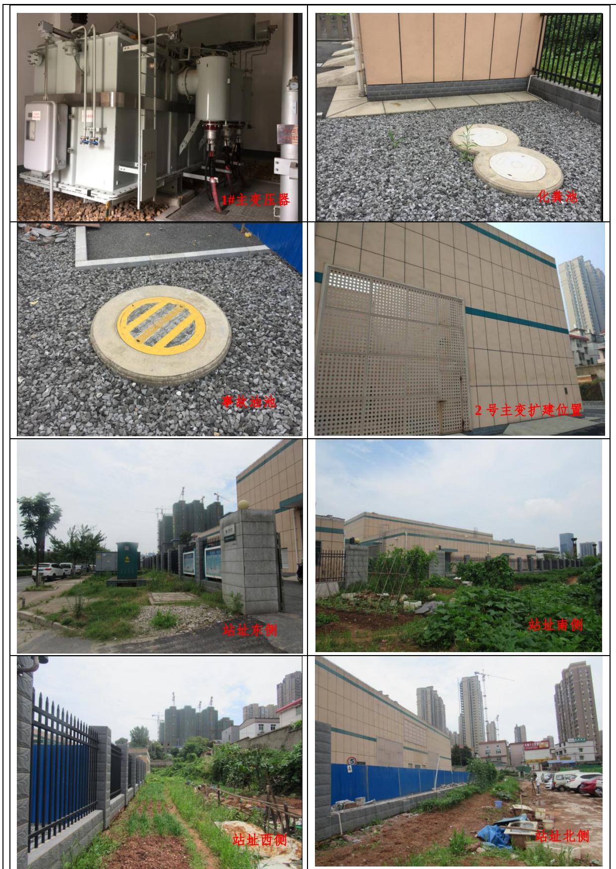
图 5 君山 110kV 变电站站内和周边环境现状
