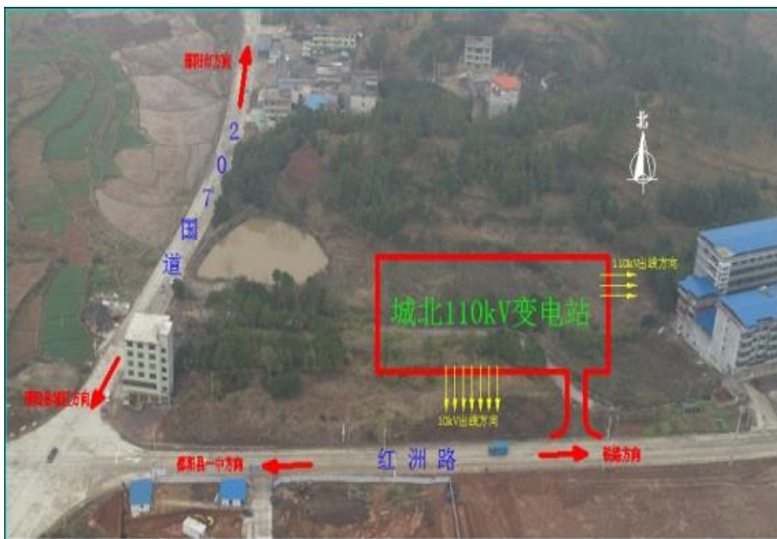
城北 110kV 变电站俯视图
