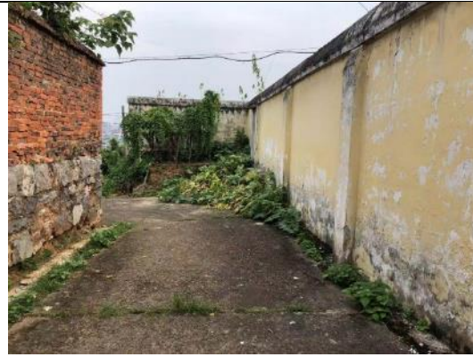
酿溪 110kV 变电站东侧厂界
