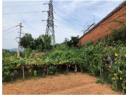
酿溪 110kV 变电站西侧厂界
