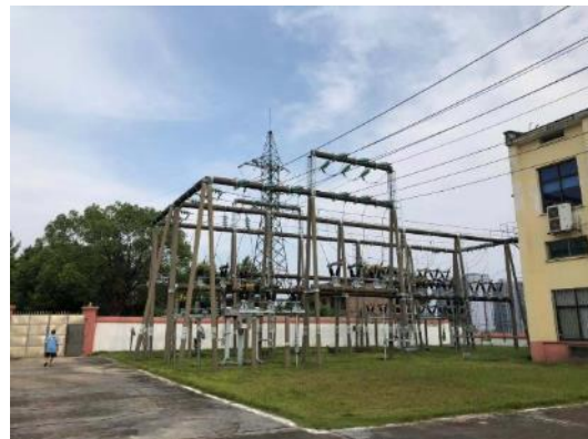
站内地面硬化及绿化
