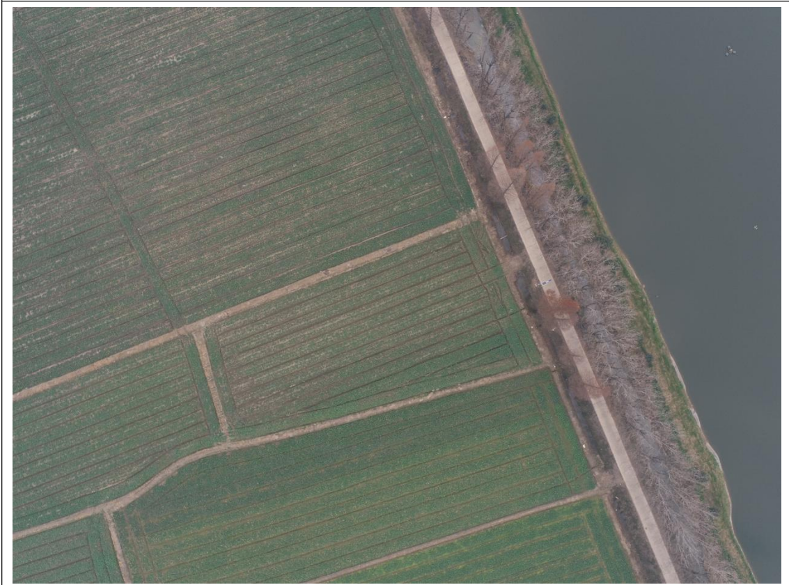
C3号塔基原始地貌，暂未开工
