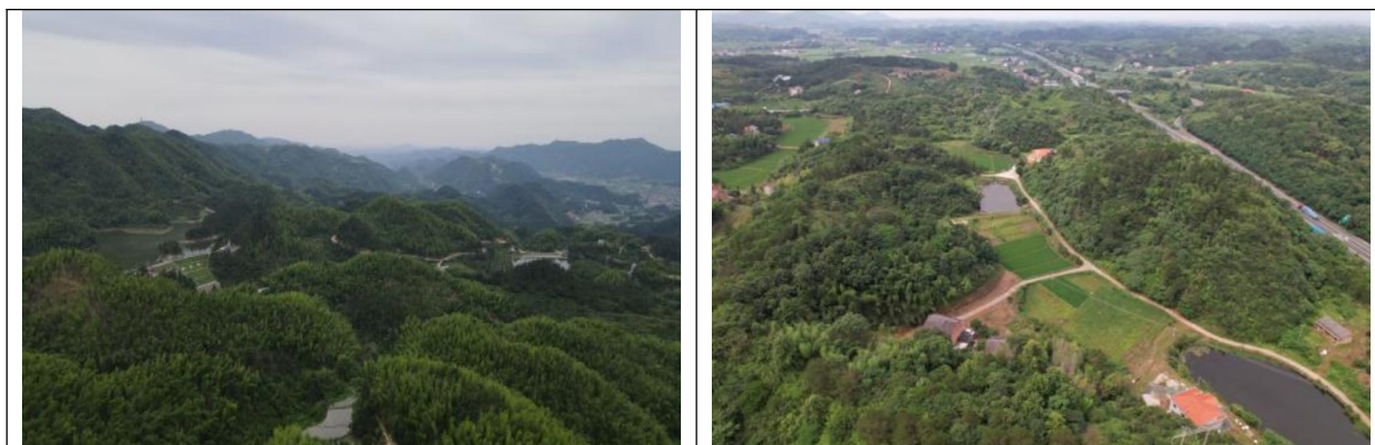
图 4-1 输电线路沿线地形地貌现状照片
